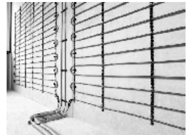
Рис. 135 Укладання полімерної труби на стіну
