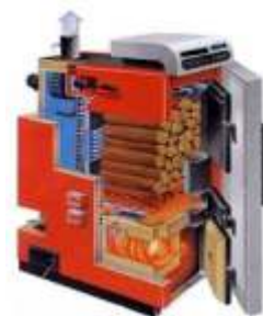
Рис.78 Котел з чавунним теплообмінником
