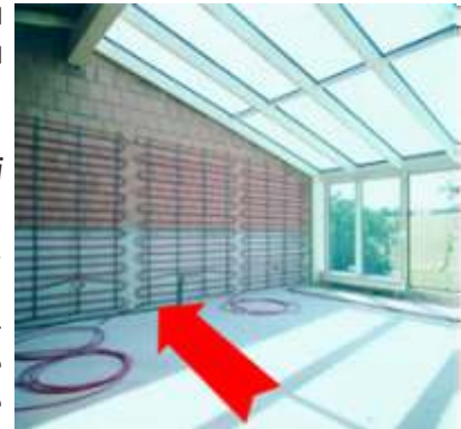
Рис.110 Водяне опалення теплими стінами
