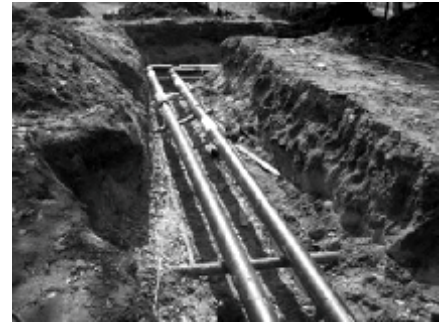
Рис. 148 Безканальне прокладання опалювальних труб
