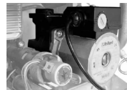
Рис.61 Двоступінчастий циркуляційний насос з ручним перемиканням
